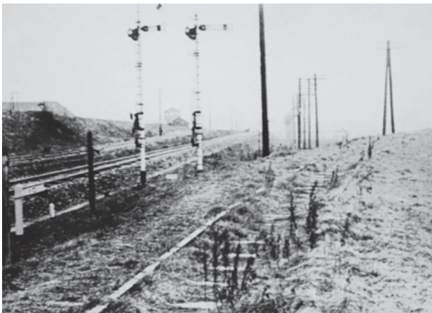
線路が敷設された戸井線（国道5号付近）
