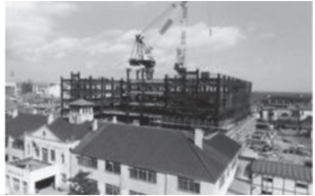
建設中の亀田支所、手前は旧亀田市役所を引継いだ庁舎
