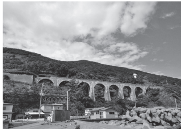
コンクリート造8連アーチ橋（汐首岬第一陸橋・旧戸井線）
