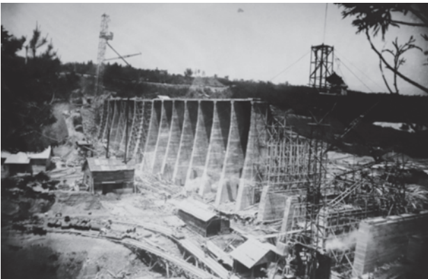
工事中の笹流ダム(大正6年～13年)
