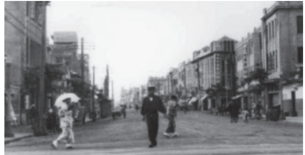
大正10年大火後の銀座通りの街並み(耐火建築物)
